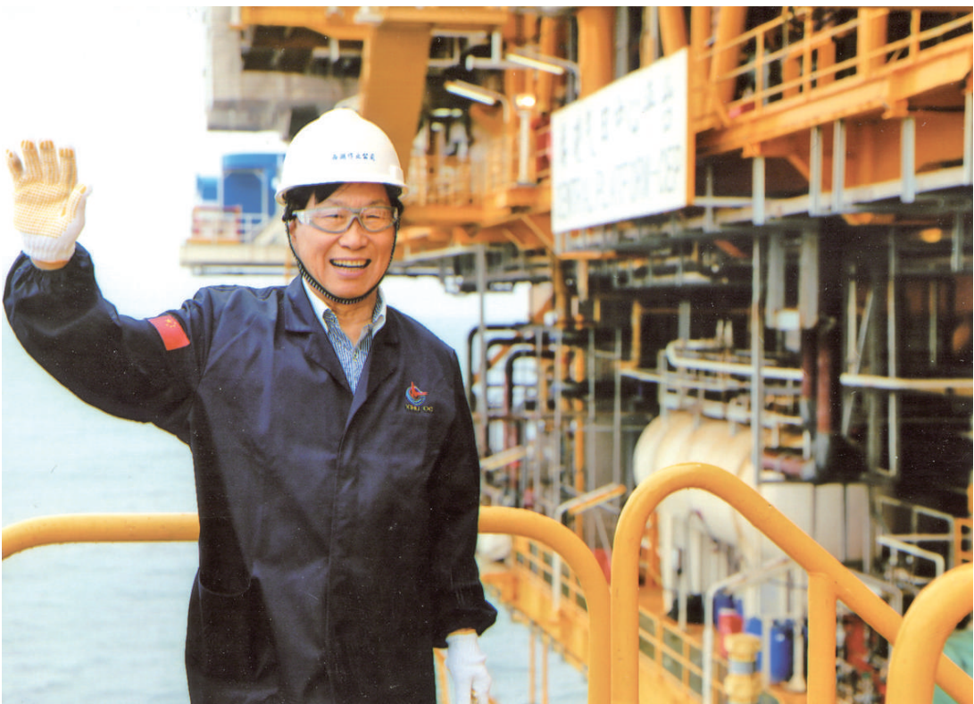
侯保荣在施工现场。
