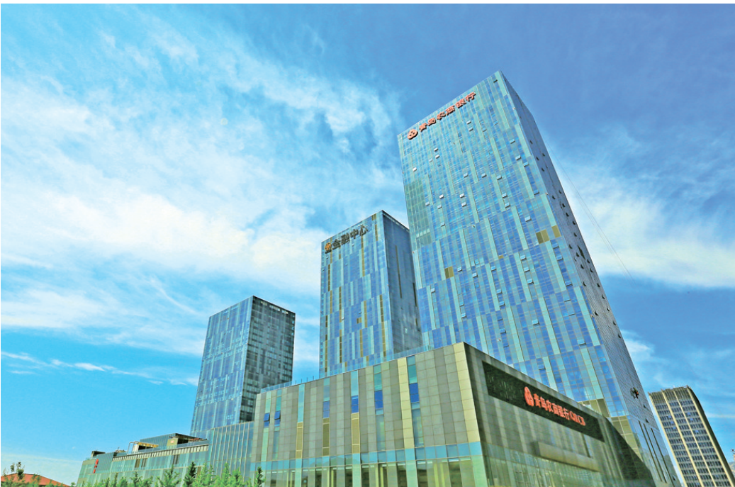
青岛农商银行总部大楼
