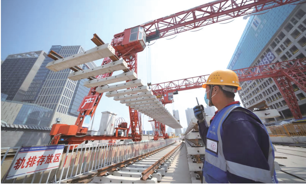
青岛地铁4号线轨道铺设现场。
