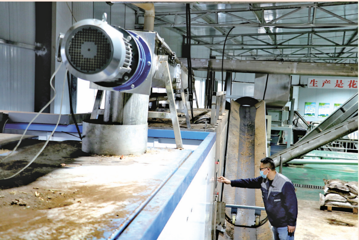
青岛沃锱环保科技有限公司员工正在调整设备数据。
