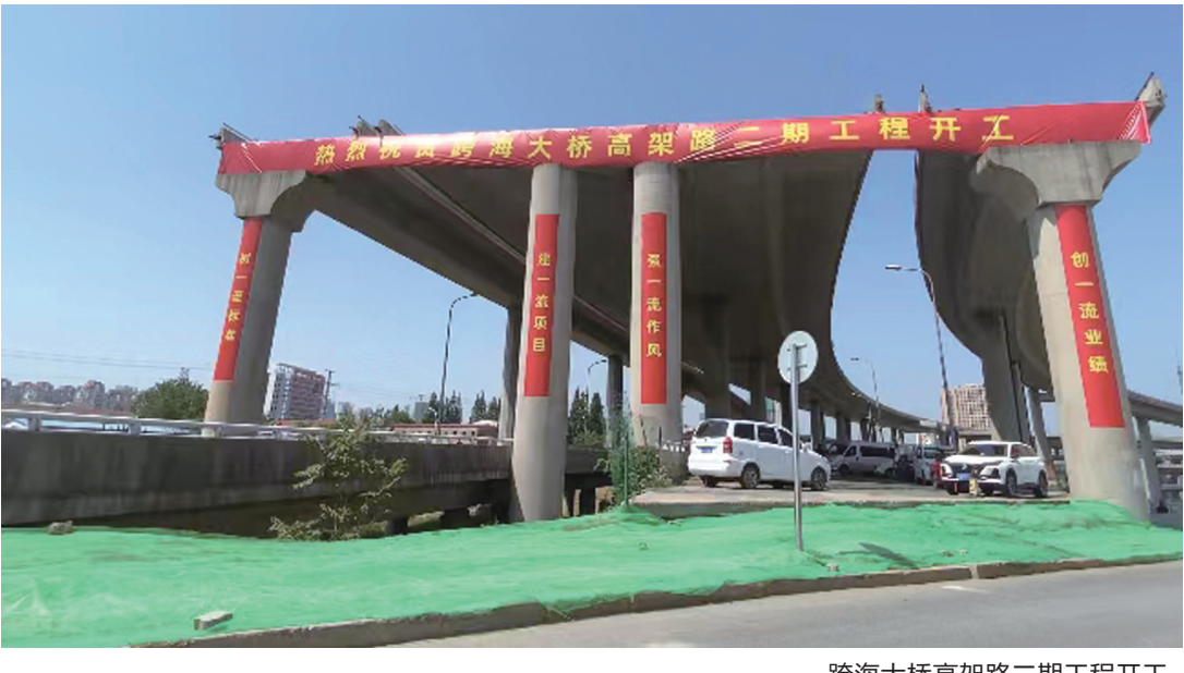
跨海大桥高架路二期工程开工。
