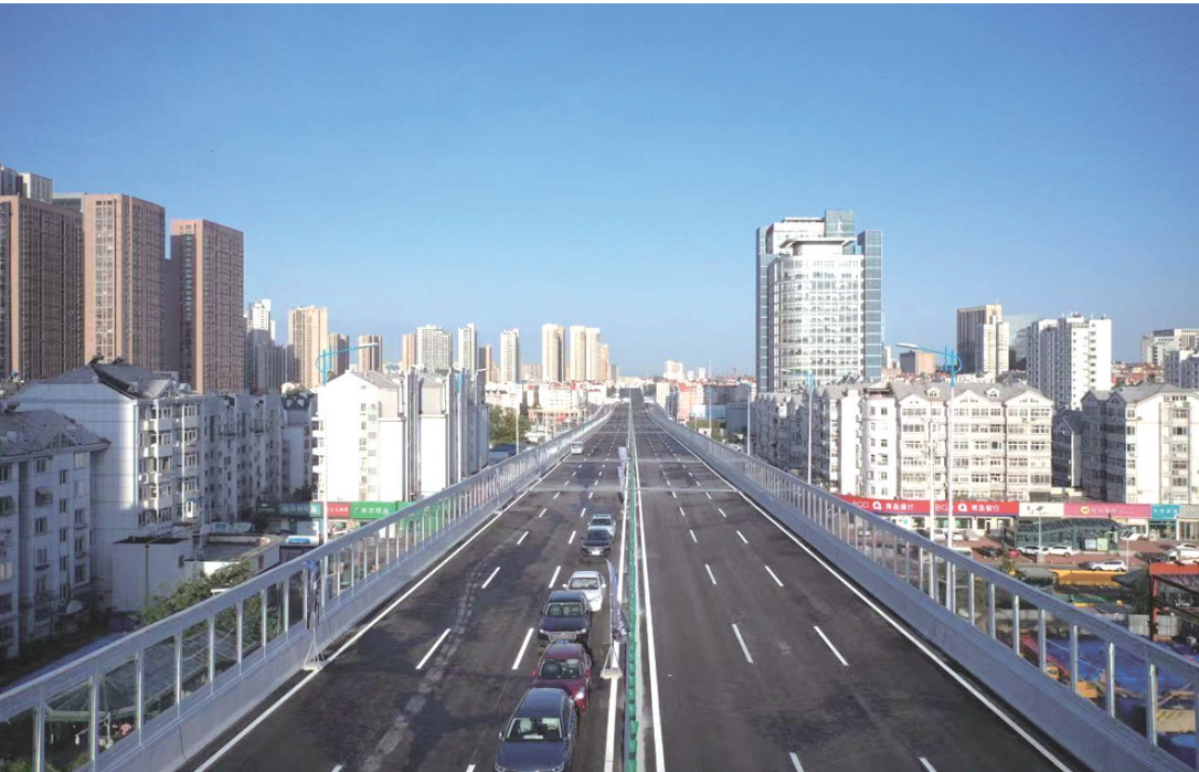
辽阳路（南京路至福州路段）交通结建工程正式通车。
