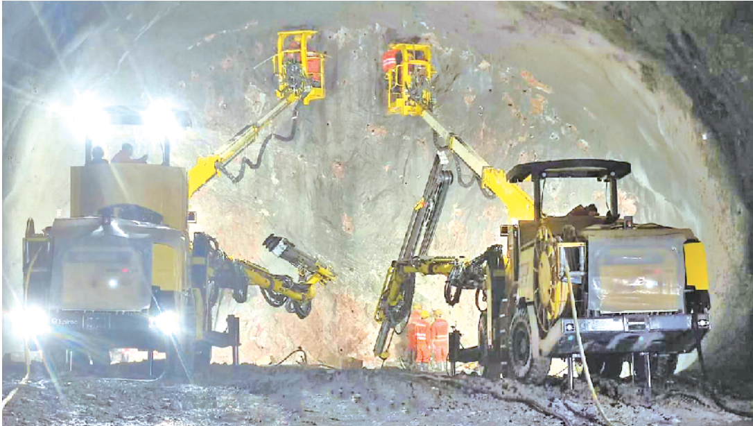
黄岛海域钻爆段施工现场。
