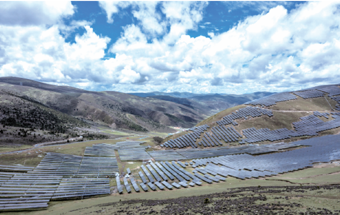
位于四川省甘孜藏族自治州雅江县柯拉乡的柯拉光伏电站。新华社发
