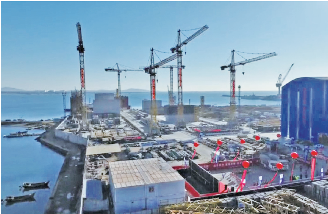
董家口港区琅琊台湾作业区工作船码头建设现场。
